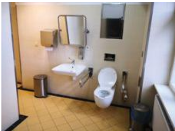
Wyremontowana ogólnodostępna toaleta przystosowana do potrzeb osób niepełnosprawnych
