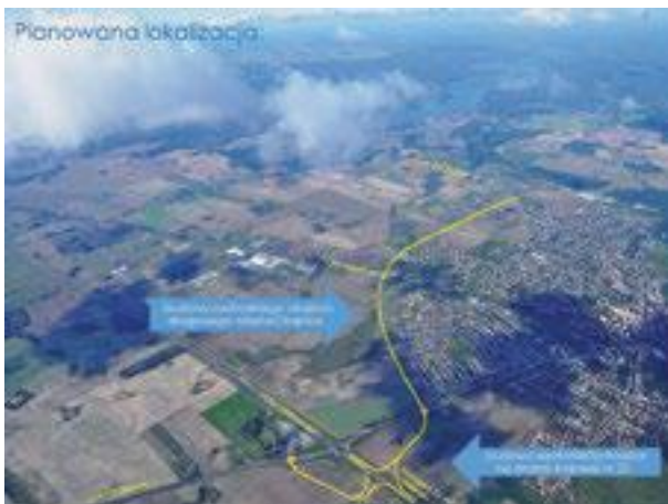
Planowana lokalizacja zachodniego obejścia miasta (fot. z arch. Urzędu Miejskiego w Chojnicach)
