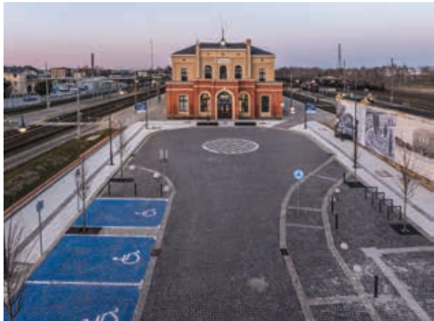
Widok z lotu ptaka na wyremontowany dworzec, parkingi i perony
